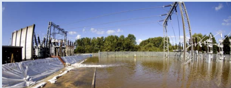
Het Walham schakelstation met een tijdelijke dam tegen het water (UK MOD, Crown Copyright (2007)).
