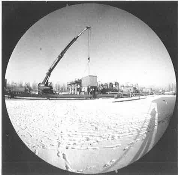
Geluidsisolerende omkastingen beschermen omgeving tegen geluidhinder van installaties.
