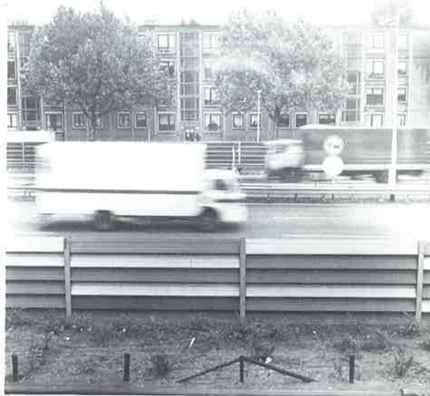
Geluidwerende wanden langs de Rijksweg.
