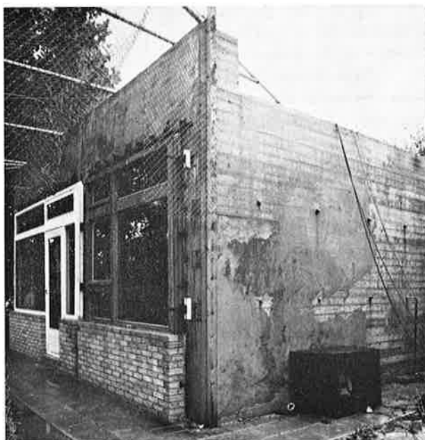
Fig. 5. Het explosieve gasluchtmengsel bevindt zich in beide vertrekken; de ontsteking is geplaatst midden in de keuken.
