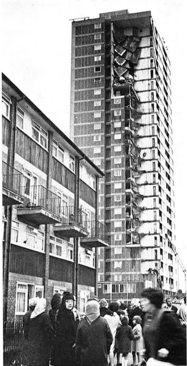
Fig. 1. Het gebouw van Ronan Point na instorting. De gasexplosie heeft plaatsgevonden op de 18e verdieping.
