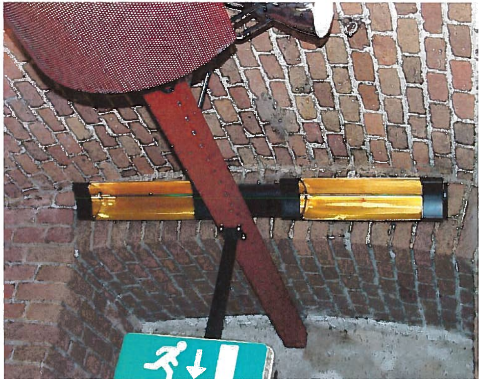
Figuur 5 Elektrische verwarming Fort De Bilt
