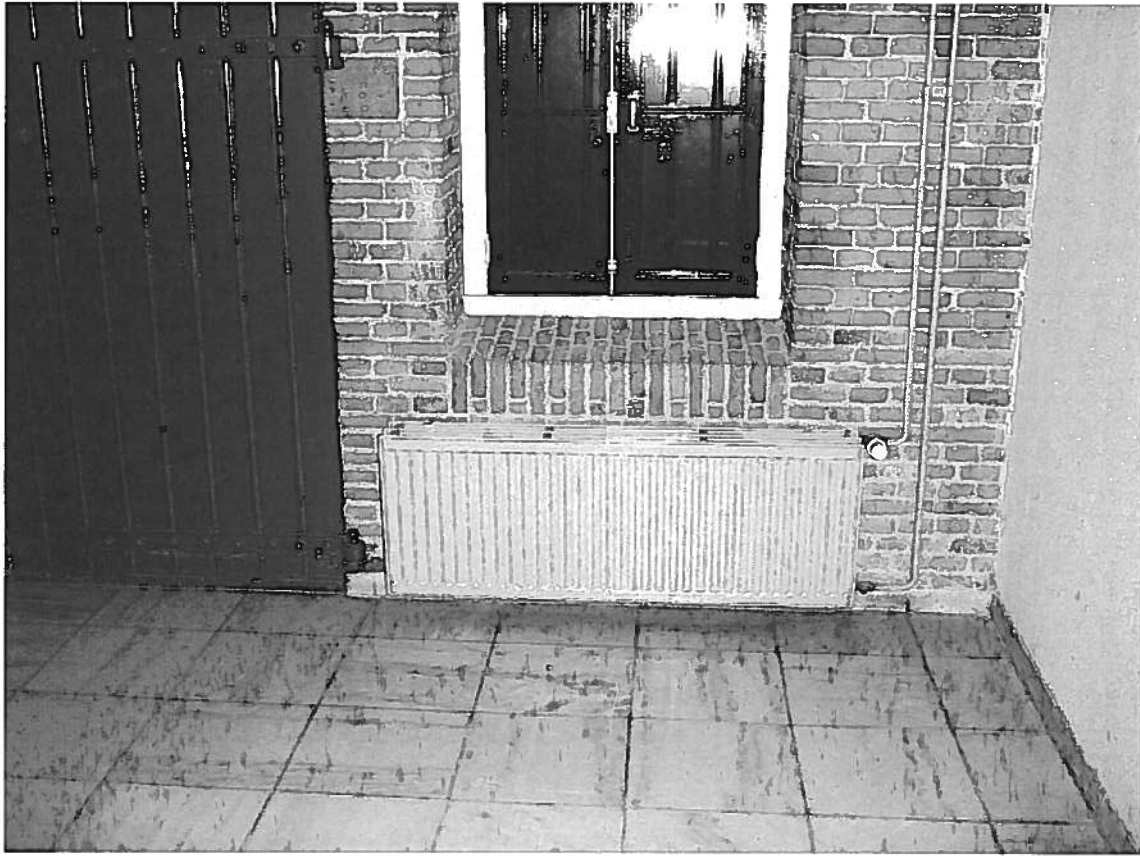
Figuur 3 Verwarming middels radiatoren in Kazerne te Muiden
