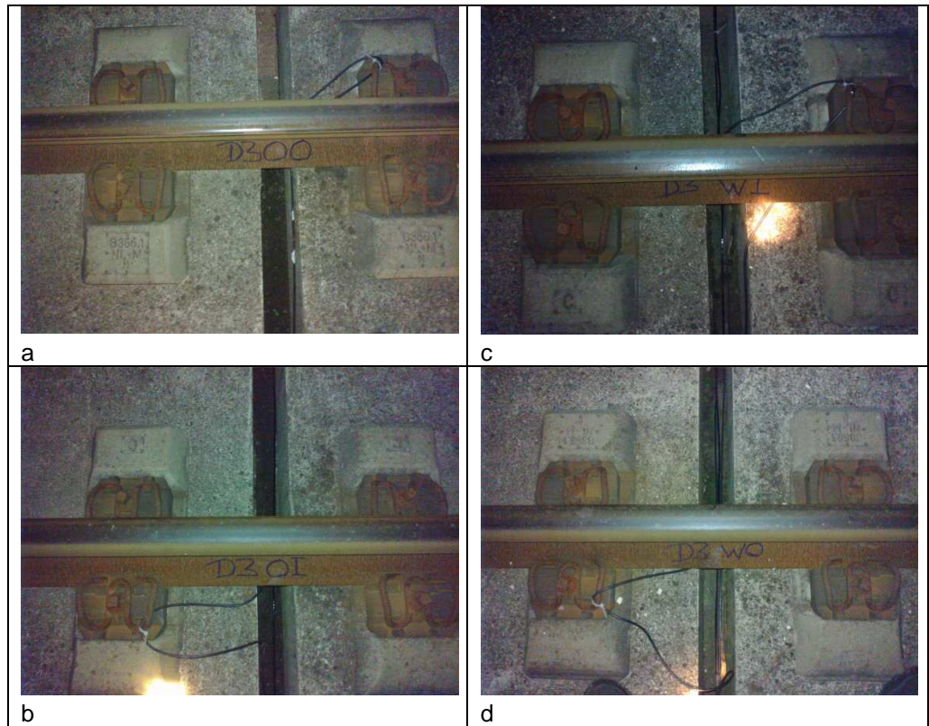
Figuur 99 Railloopvlak vóór de referentiemeting op meetdoornede 3, a) oostspoor buitenrail, b) oostspoor binnenrail, c) westspoor binnenrail, d) westspoor buitenrail.
