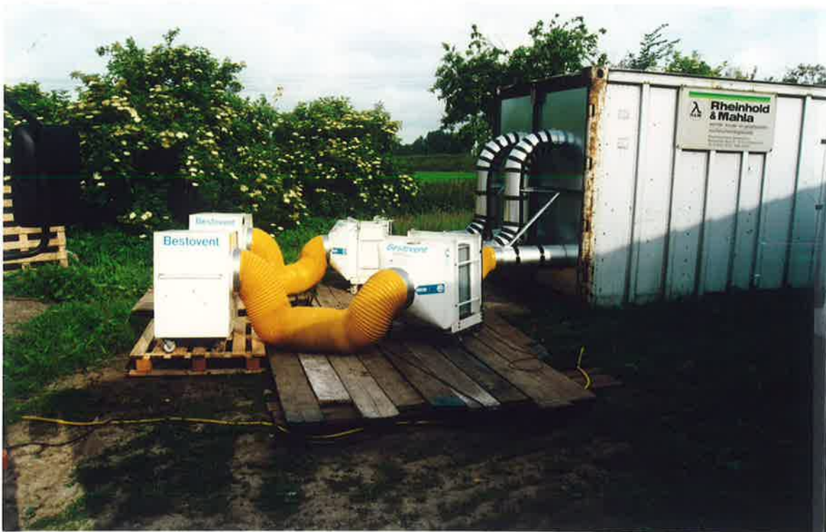
Figuur 3.1 Deel van het containment met onderdrukmachines en (HEPA)filterunits aan de 'voorzijde'.
