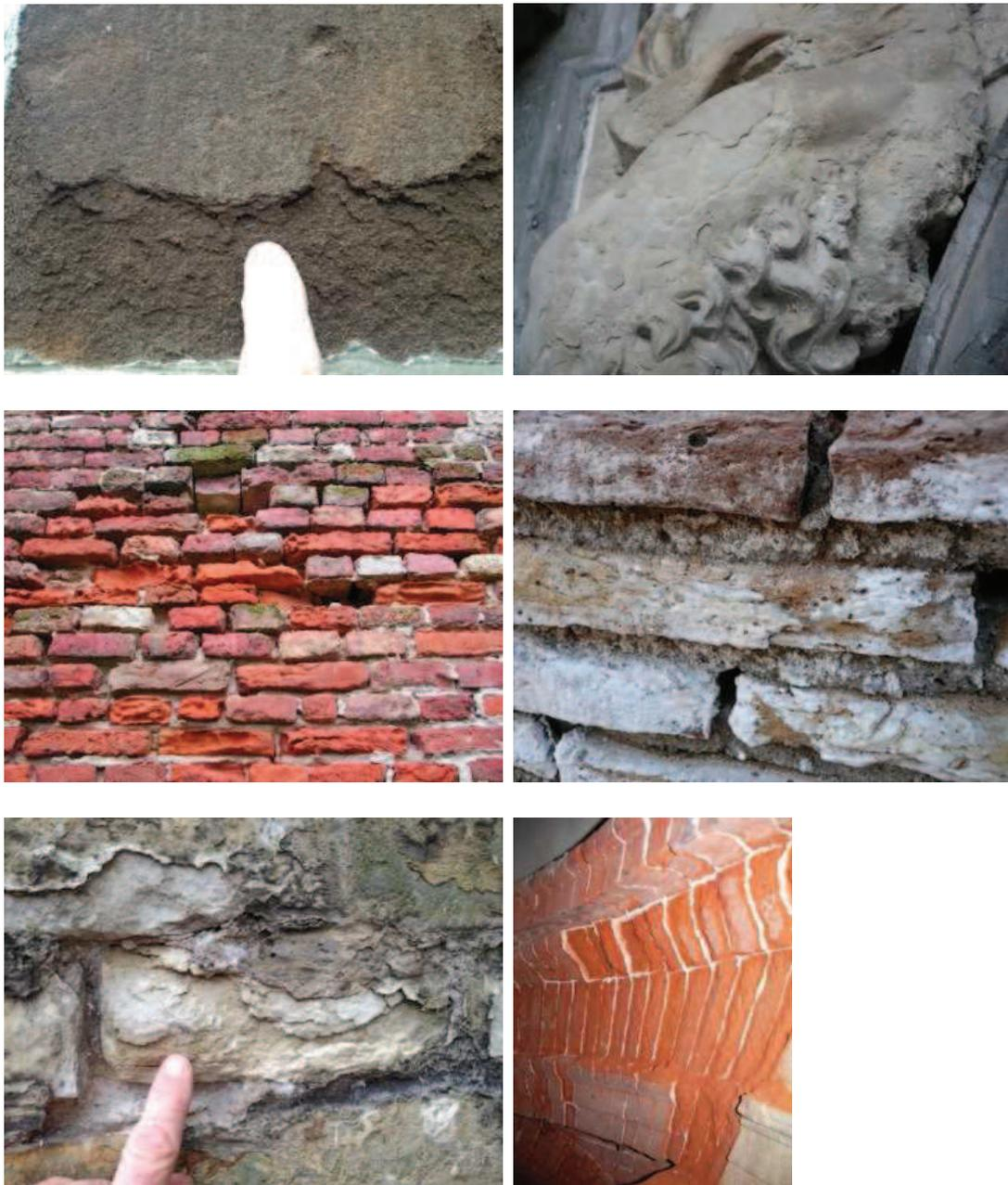
*Fig. 1. Enkele voorbeelden van gedegradeerde natuursteen en baksteen. Voor toelichting, zie tekst.*
