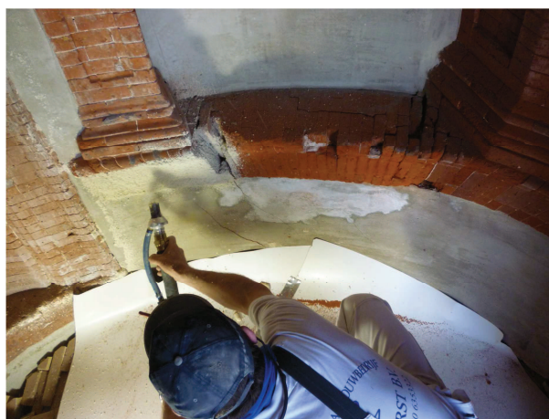
Fig. 4. Machinaal aanbrengen van de poultice.
