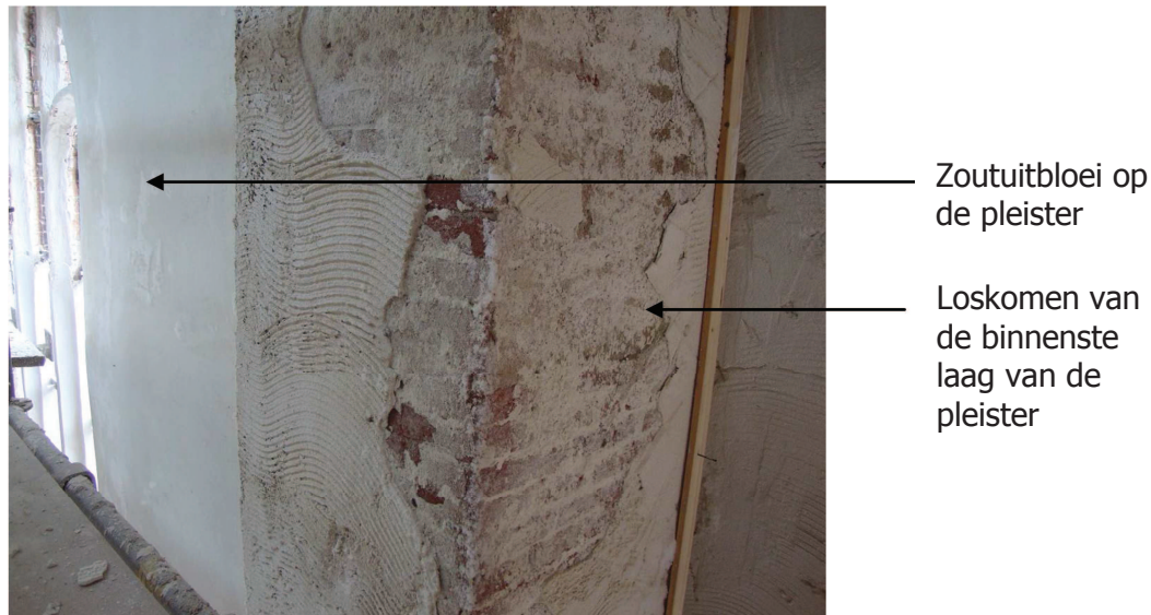
Fig. 2. Loskomen van de eerste laag pleister, enkele weken na het aanbrengen op een natte, zoutbelaste muur. Op de pleister is zoutuitbloei zichtbaar.
