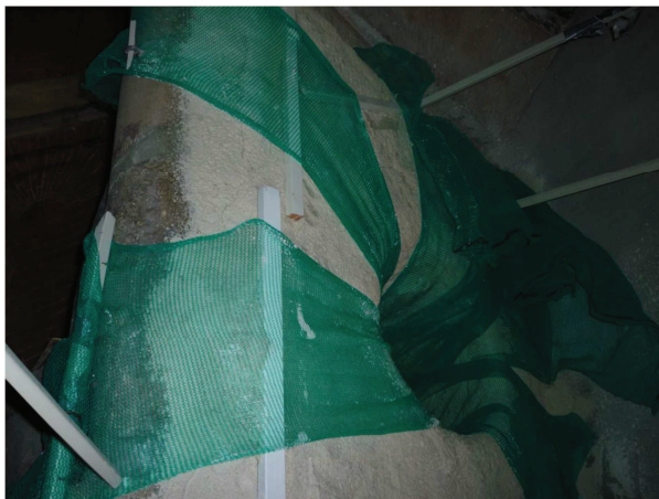
Fig. 5. Gebruik van een net om goed contact tussen de poultice en de ondergrond te garanderen.
