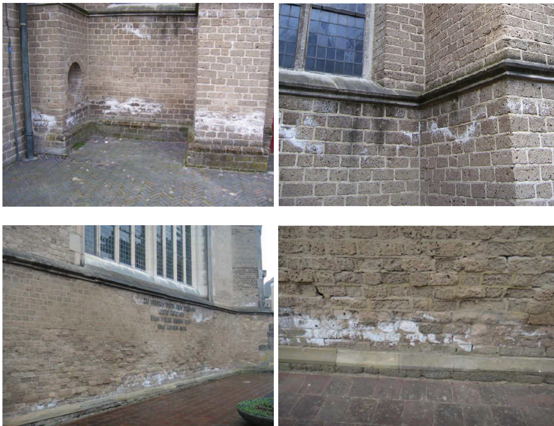
Fig. 12. Aantasting van Römer tuf door \text{Na}_2\text{SO}_4 aan de Pieterkerk in Utrecht (2010) en de Lebuïnus in Deventer (2013); in het laatste geval is de aard van het zout aangetoond met XRD; in het eerste waarschijnlijk op basis van uitsluiting.
