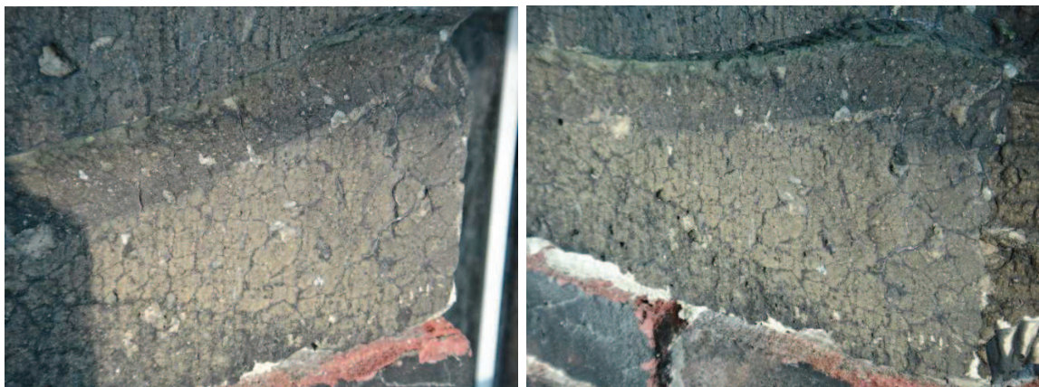
Fig. 9. Voorbeelden van vorming van een harde, gecraqueleerde donkere korst op tuf aan de lantaarn van de toren van de Faculteit Bouwkunde van de TU Delft (2014).
