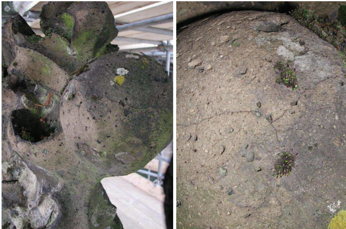
Fig. 8. Voorbeelden van vorming van een harde, gecraqueleerde donkere korst op Weiberner tuf op een hogel op de luchtbogen van de St. Janskathedraal te 's-Hertogenbosch (2003).
