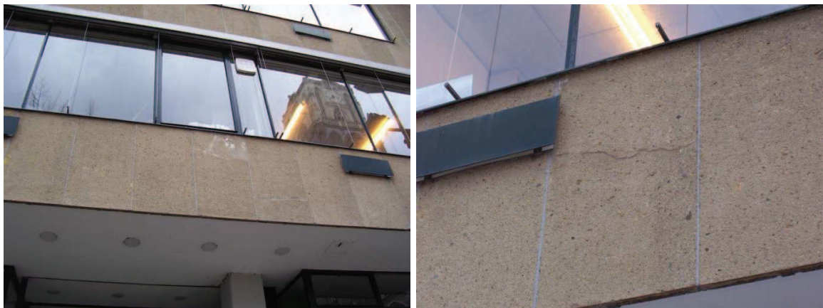
Fig. 5. Scheurvorming in platen Ettringer tuf aan gebouw De Heuvel in Rotterdam (2006). De platen zijn bij de laatste restauratie vervangen door Muschelkalk.
