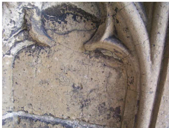
Fig. 7. Voorbeelden van vorming van een harde, gecraqueleerde donkere korst op Weiberner tuf in de driepas van een pinakel van de St. Janskathedraal te 's-Hertogenbosch (2006).
