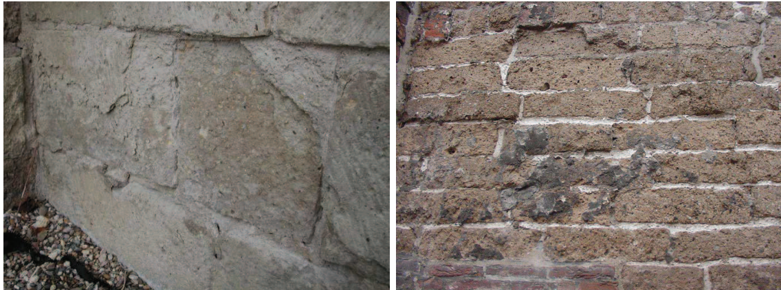
Fig. 3 (links). Exfoliatie van Weiberner tuf direct boven het maaiveld aan de Oude Kerk in Oosterbeek (2002). Fig. 4 (rechts). Afspringen van 11 e eeuwse Römer tuf aan de Janskerk in Utrecht (2002).
