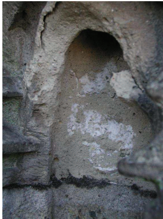
Fig. 13. Aantasting van Weiberner tuf door \text{Na}_2\text{SO}_4 aan een pinakel van de St. Janskathedraal te 's-Hertogenbosch (2002). De aard van het zout is aangetoond door XRD.
