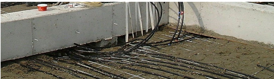
Figuur 18 Horizontaal niveau gekozen onder de funderingsbalken.
