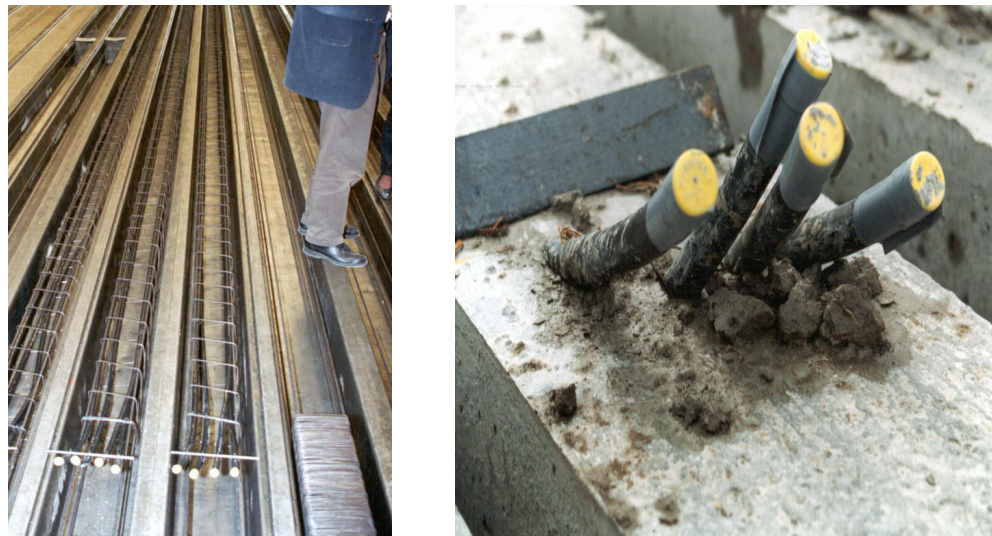
Figuur 10 Mallen voor de energiepalen (links) en de uiteinden van de pijpen in de energiepaal (rechts).
