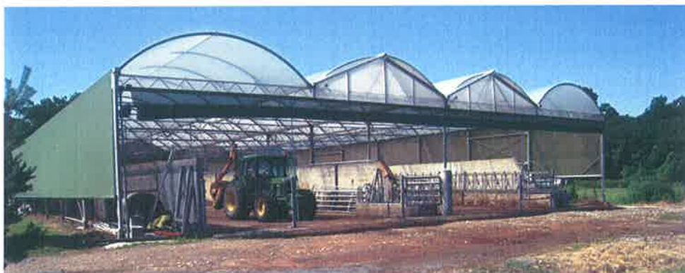
Figuur 1: Serrestal: Voorbeeld van een betaalbare en effectieve oplossing voor goede ventilatie.
