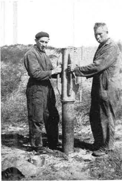
Afb. 1. Het indrijven van een stalen buis in de grondlaag tussen maaiveld en 1 m daaronder.
