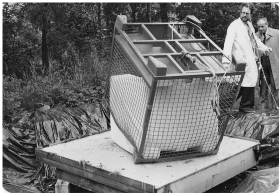
De beginfase van het testen van IBC's: Jaap Bodde en Kees van der Lingen treffen voorbereidingen voor de valtest en Kees bekijkt samen met de klant het resultaat, waarbij Kees, zoals gebruikelijk, adviezen geeft voor verbetering van het verpakkingsconcept
