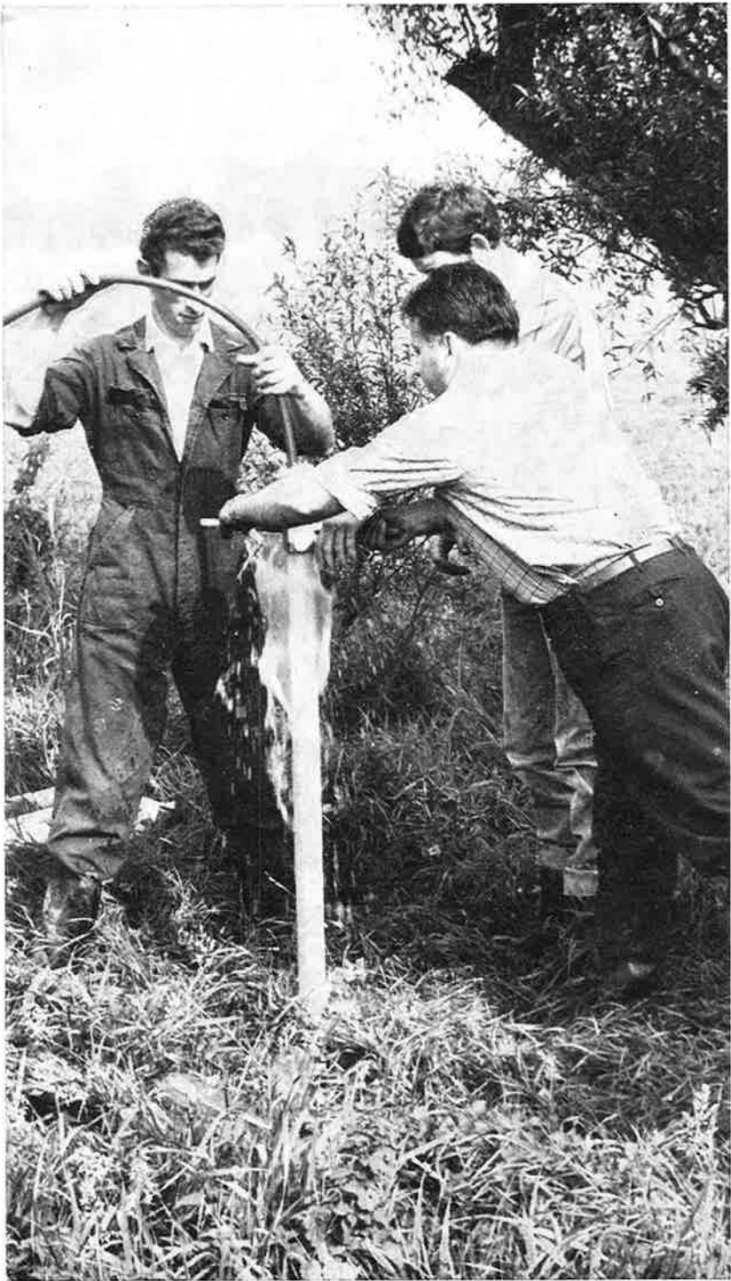
Lichte spuitboorinstallatie voor peilbuizen tot 10 m diepte. Dienst Grondwater- verkenning TNO
