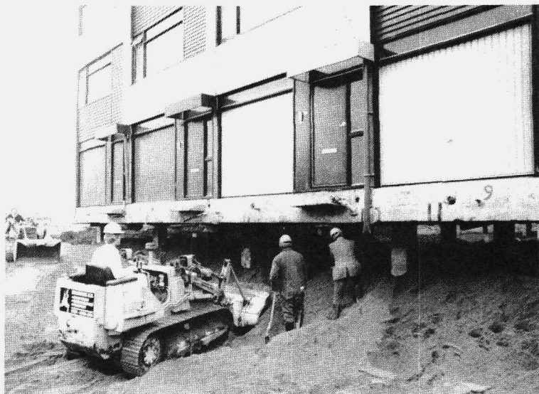
1.3. In Lekkerkerk vond in 1980 Nederlands eerste grootscheepse bodemsaneringsoperatie plaats. De vervuilde grond werd onder de woonhuizen weggegraven, waarna er schoon zand voor in de plaats werd aangebracht.
