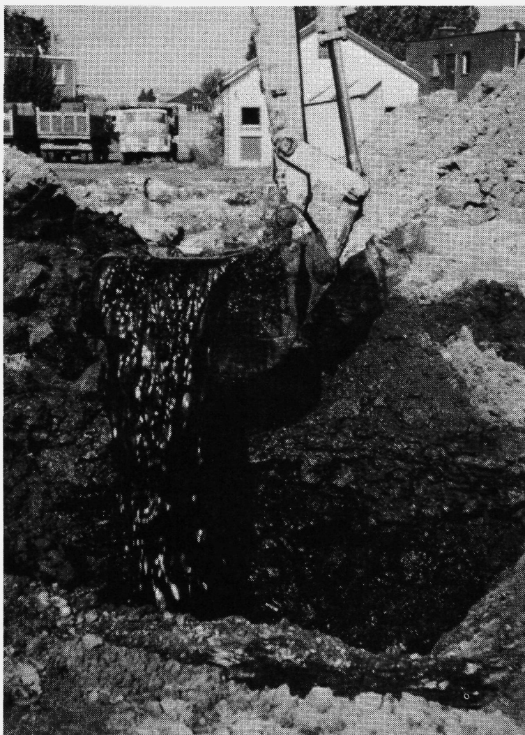
3.4. Bij het onderzoek van een voormalig fabrieksterrein werden een ernstig verontreinigde bodem en dito grondwater aangetroffen.
