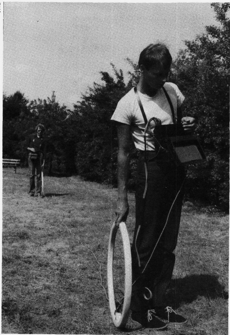
3.7. Met elektromagnetische meettechnieken wordt de omvang van de verontreiniging in de grond vastgesteld, zonder dat er boringen voor nodig zijn. Door de spoelen wordt een wisselstroom gestuurd die elektromagnetische velden opwekt. Naarmate de 'schijnbare' weerstand lager is, moet een grotere verontreiniging worden verwacht.
