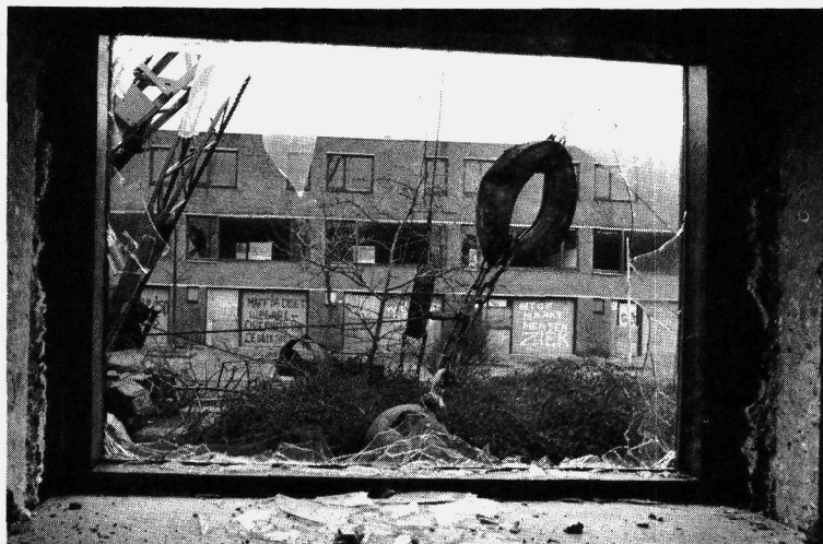
4.2. In de Merwedepolder in Dordrecht werden 106 woningen gesloopt nadat daar in september 1981 bodemverontreiniging was geconstateerd.
