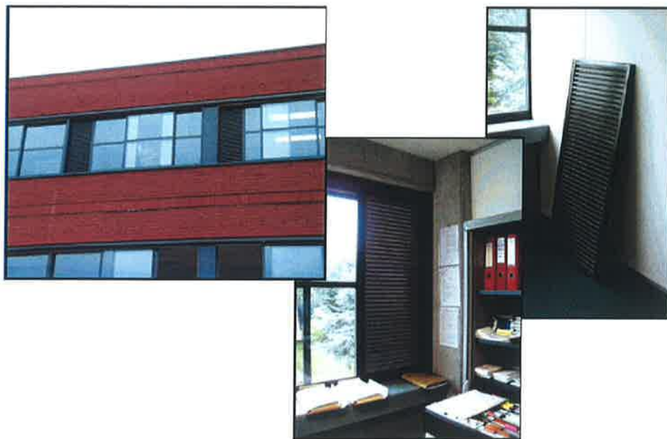
Figuur 4.14: Voorbeeld van inbraakveilige en regendichte grote ventilatieroosters in het gebouw Keppekouter (België), foto CD-rom NatVent, EU-Joule project
