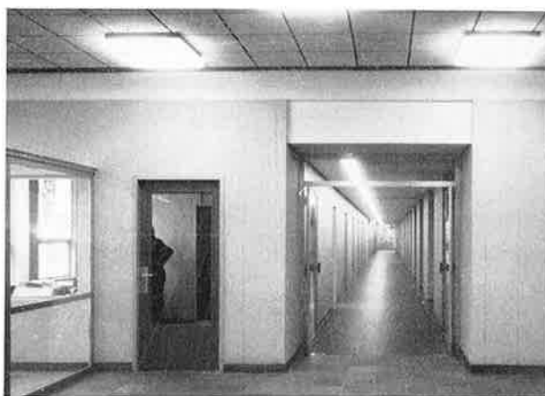
Fig. 2. Asymmetrische verlichting van de 50 m lange gangen. Geen donkere plekken zijn aanwezig door het overlappend monteren van de 65 Watt TL-buizen.
