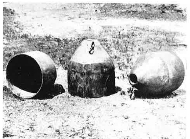
Fig. 1. Koppen voor het uitslepen van stammen uit het bos, volgens Lhota. Deze uitsleepkoppen dragen aan de binnenzijde een gepatenteerde klem, welke alle mogelijke bewegingen van de stam toelaat, zoals b.v. draaien om de as.
