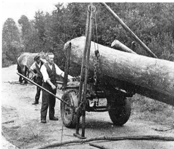
Fig. 4. Nadat de stam omhoog gebracht is, wordt er voorlopig, ter ondersteuning, een wielstel onder gereden.
