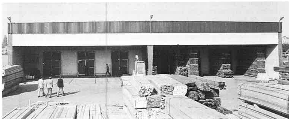
Fig. 59: Twee grote geklimatiseerde droogruimten naast elkaar onder één dak geplaatst.
