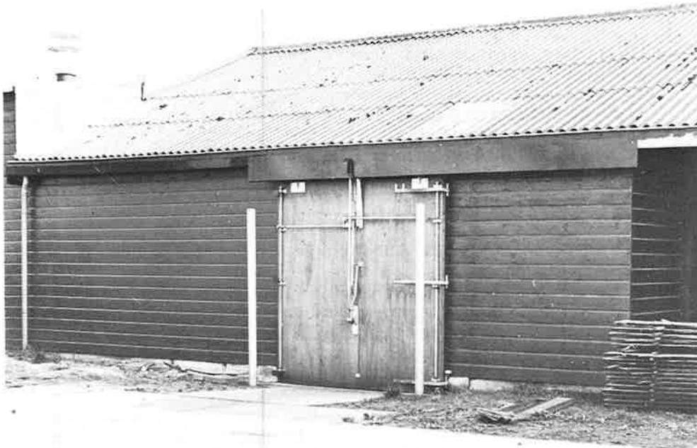
Fig. 57: Een kleine geklimatiseerde droogruimte, ondergebracht in een gedeelte van een bestaande houtloods van een kleinere meubelfabriek.
