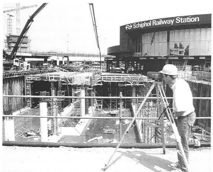
Bouwput voor de ondergrondse Schiphollijn.
