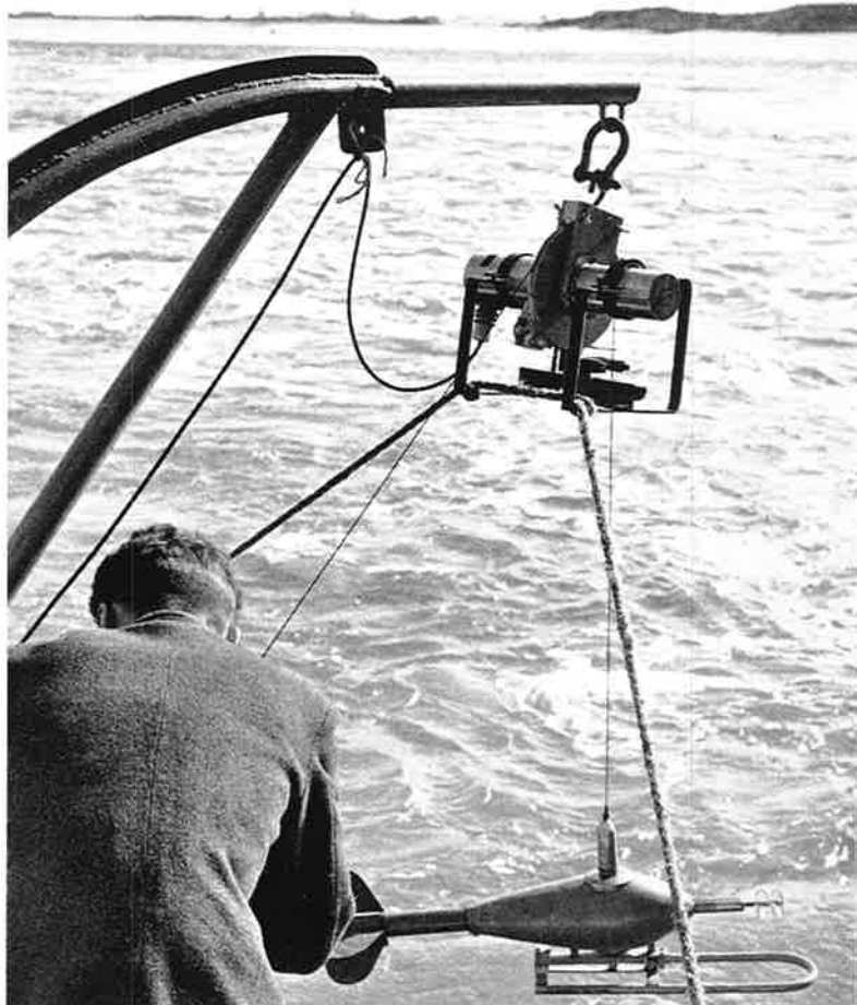
De watersnelheidsmeter wordt in de Zeeuwse wateren neergelaten.
