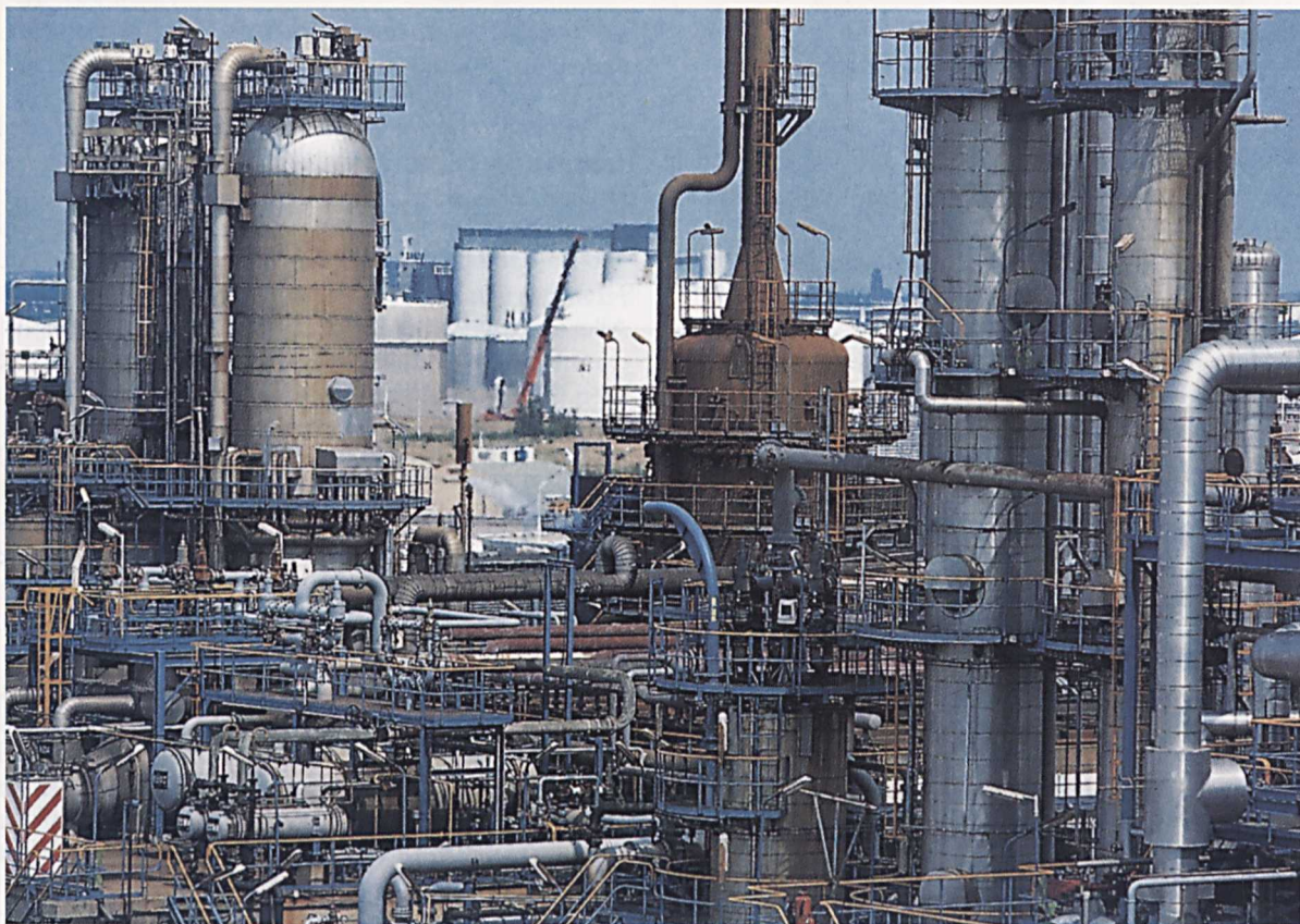
Figuur 1. Bij een eenmaal geïnstalleerde plant is het kostbaar om veranderingen aan te brengen. In de ontwerpfase is daarentegen eenvoudig de omgeving aan te passen zodat bijvoorbeeld afsluiters goed bereikbaar zijn.
