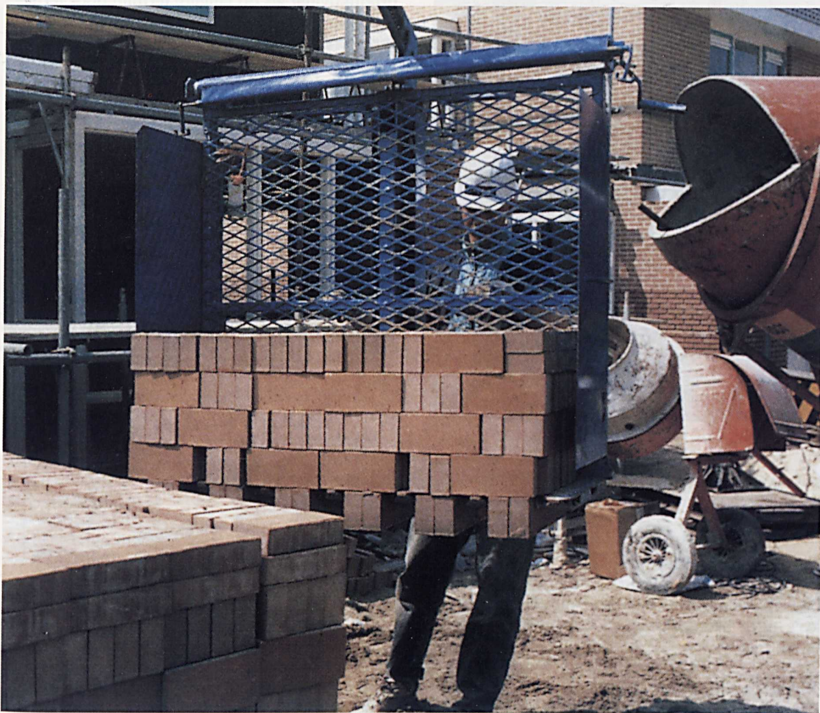
Figuur 1. Een tang, die een grote hoeveelheid stenen op de steiger kan plaatsen
