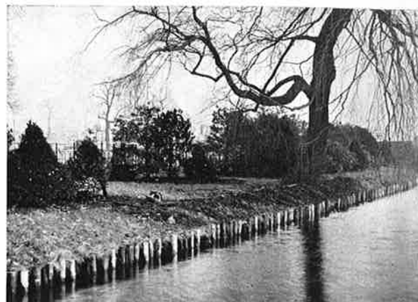
Fig. 5. Gezicht op de in het water geplaatste palen.
