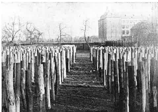
Fig. 4. Gezicht op de in de grond geplaatste palen.
