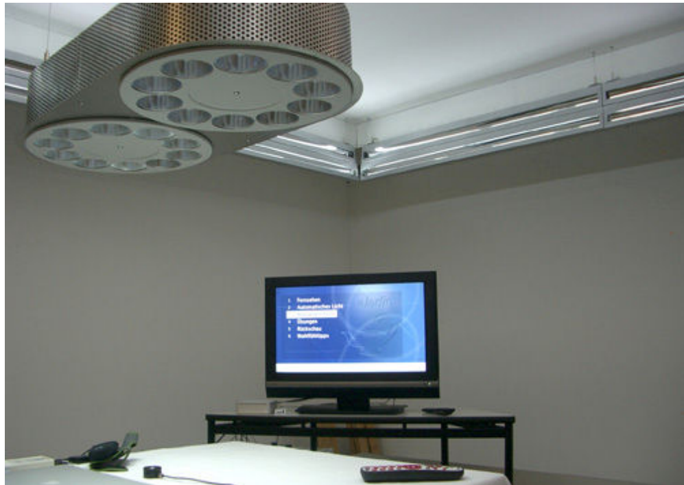
Foto 1, onderdelen Aladin systeem: een directe lichtbron in de vorm van een hanglamp. Indirecte verlichting ter plaatse van het plafond aangebracht tegen alle vier de wanden van de ruimte, televisie voor bediening van het systeem, de afstandsbediening en de biohandschoen. Bron: Kempter (2009)
