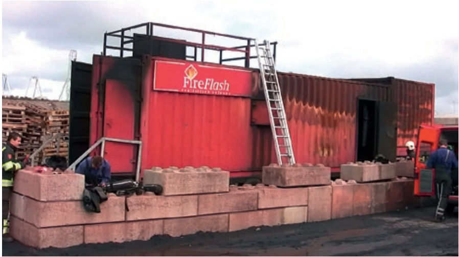
Figuur 13 Overzichtsfoto van de flash-overcontainer die diende als testlocatie voor aan HIMS toegevoegde sensoren voor het monitoren van gevaar door chemische stoffen.
