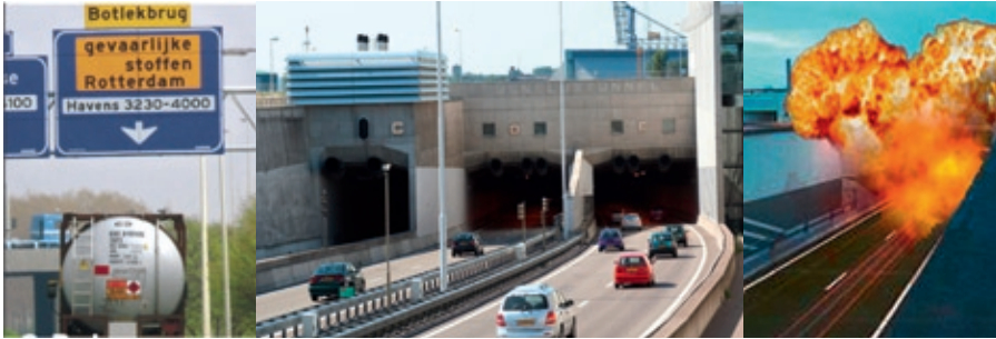
Figuur 3 Het verbieden van transport van explosiegevaarlijke stoffen door tunnels is een logistiek knelpunt.
