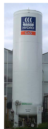
Figuur 4 Vloeibare CO 2 opslag
