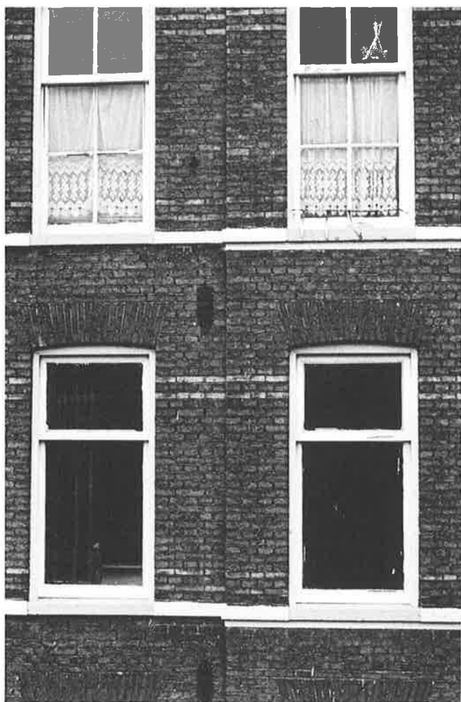
Afbeelding 1: Kleine ruitjes (zoals boven in de foto) hebben meer kieroppervlak dan grote. (foto Henk Thomas)
