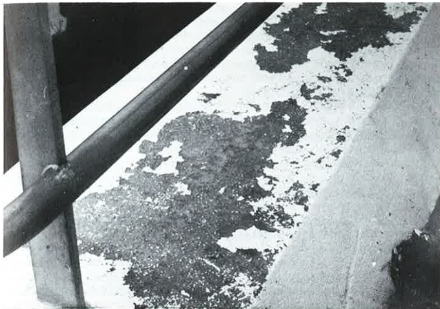
Foto 17: Schade door afvriezen van verf en beton
