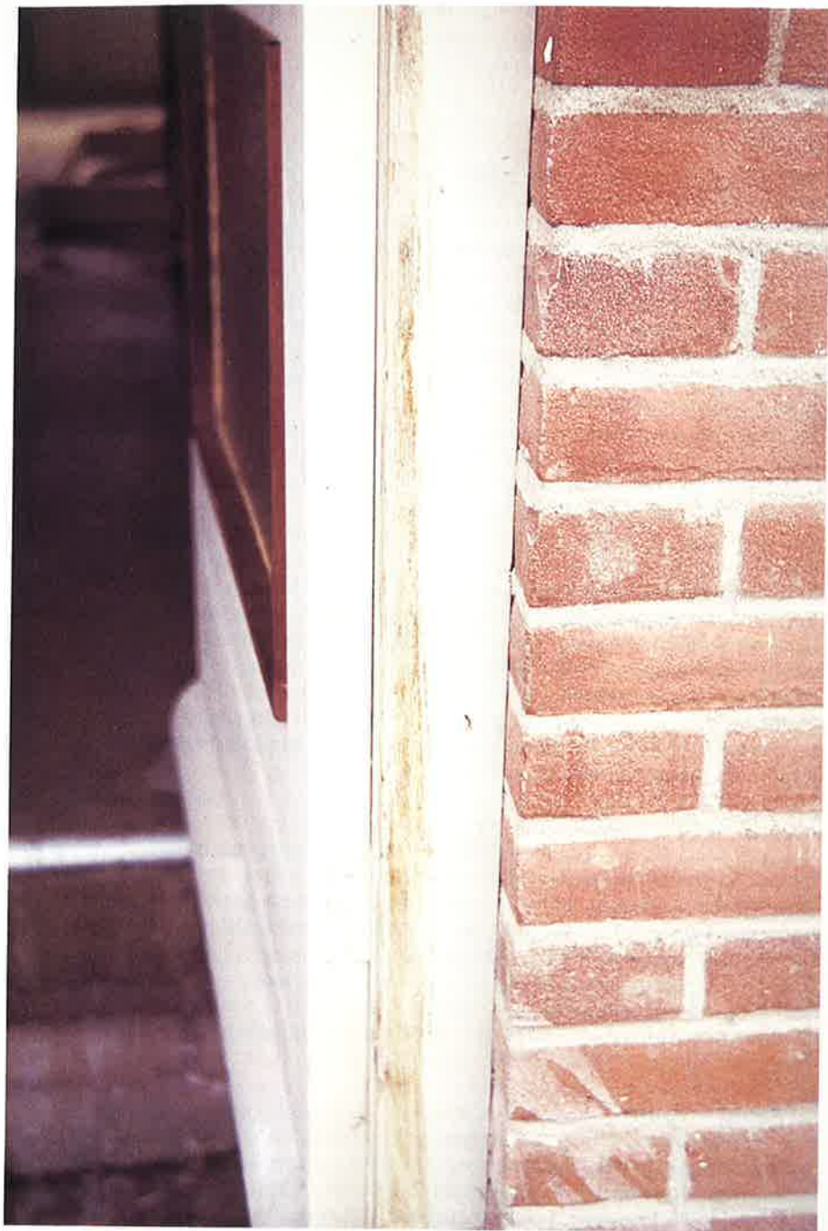
Foto 4: Verkleuring van de verf door een overmaat verduurzamingsmiddel
