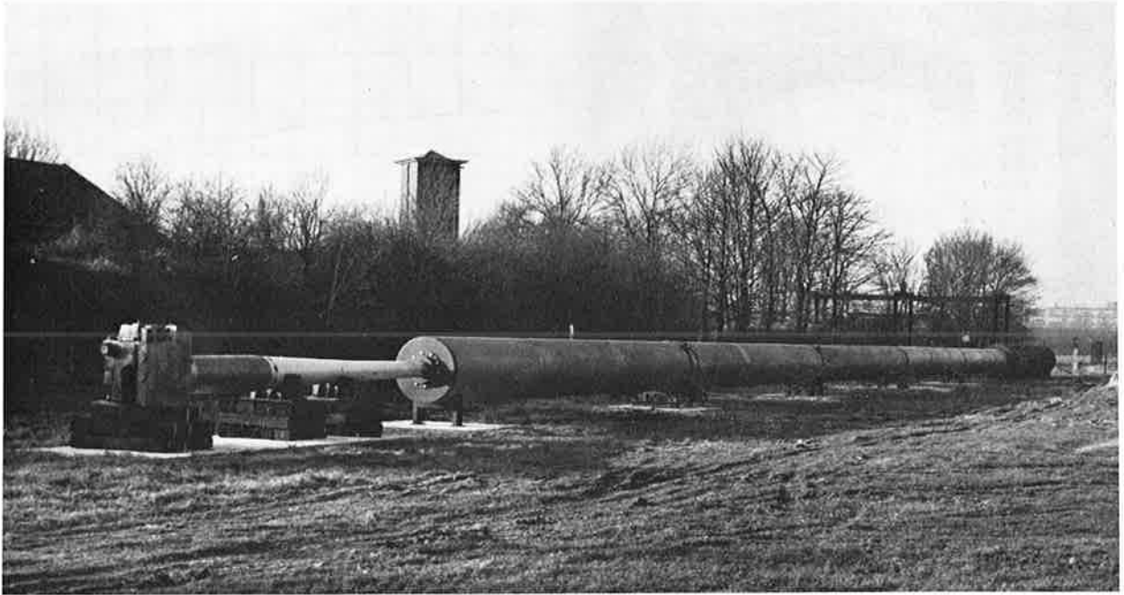
Fig. 5. De 85 m lange blasttunnel op het RVO-terrein te Rijswijk voor het onderzoek van de interactie van schokgolven met constructies. Het hogedrukgedeelte (kanonloop) bevindt zich links op de foto. Dit wordt gevolgd door een 60 m lange buis van 1 m diameter en ten slotte door een 16 m lange buis van 1,5 m diameter.
