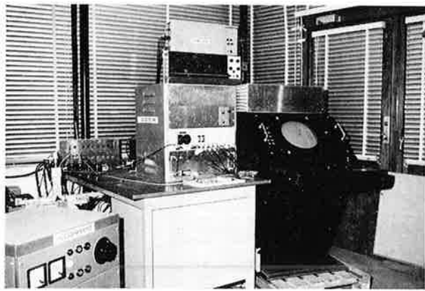
Fig. 4. Complete radarinstallatie van de lineaire array. Te zien is o.a. van links naar rechts: de hoogspanning van de generator, de detector unit en de radarbeeldkast. Achter en boven de detectie unit staat de computer.
