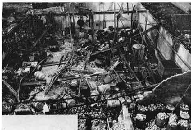
Fig. 4. Verwoesting van een verffabriek door de thermische explosie van cellulosenitraat, gevolgd door brand.
