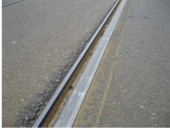
Figuur 6 Tramrails (breedte 0.115 m) met goot (0.07 m) ernaast. Het totaal komt daarmee op 0.185 m breedte, overeenkomend met een zeer gangbare bandbreedte voor kleine en middelgrote personenauto's.
