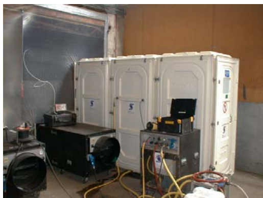
Foto: Onderdrukcabine bij asbestsanering
