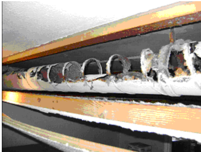
Foto 6: Transportleiding waarvan leidingmateriaal grotendeels is verdwenen.
