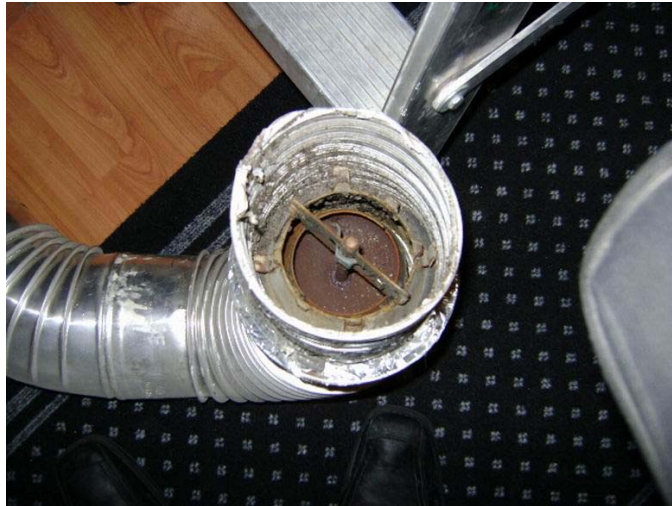
Foto 5: Stromingsbegrenzer in de rookgasafvoer van de ketel
