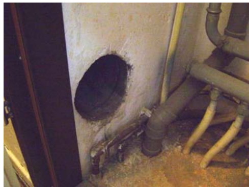
Foto 2 toevoer opening verbrandingslucht in werkkast
