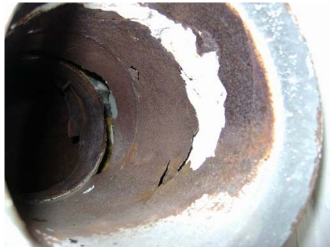
Foto 4: Aansluiting rookgasafvoer ketel op het afvoersysteem
