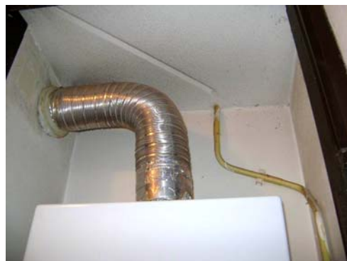
Foto 3 Aansluiting rookgasafvoer op het centrale afzuigsysteem
