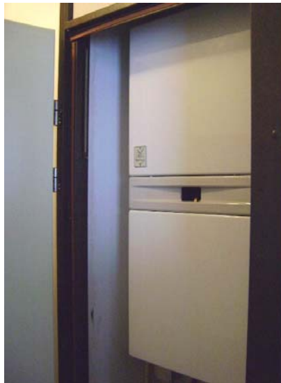
Foto 1 Werkkast met combiketel
